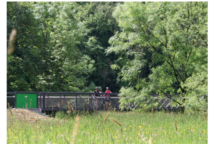
↑ Über sieben Brücken führt der Radweg im Ohrntal
