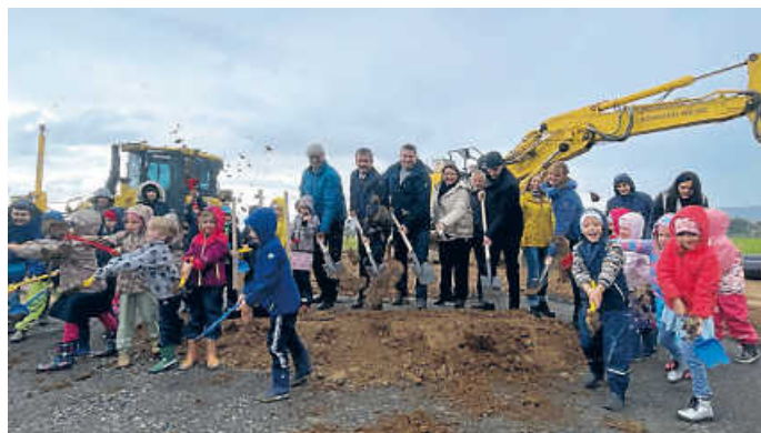
Hier packen alle an, ob OB, Kinder und Gemeinderäte: Spatenstich zur neuen Grundschule im Limespark Foto: Stadt Öhringen
