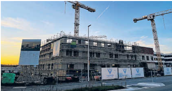
Krankenhaus-Baustelle Stand 4. Oktober
